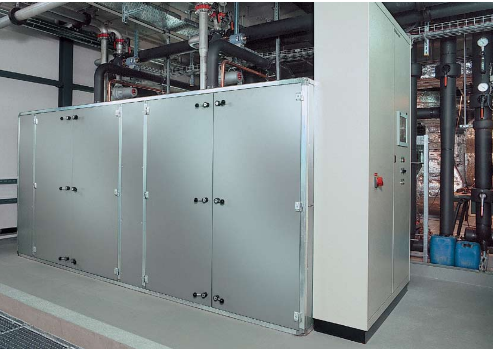
KWT water/water-warmtepomp met een verwarmingsvermogen van 500 kW
