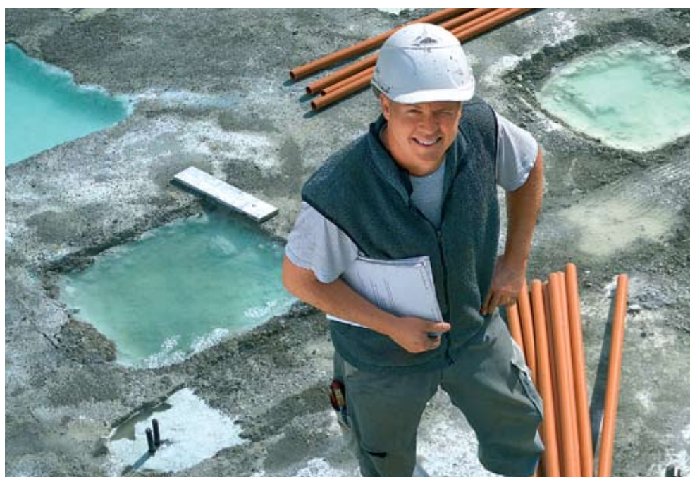
Paalfundering met aardwarmtesondes
