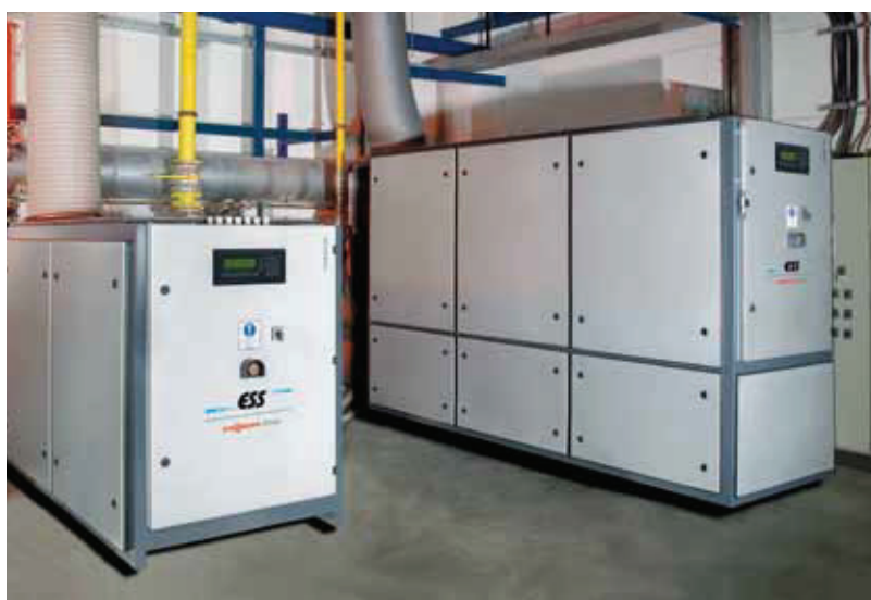
De Vitobloc 200 is standaard uitgerust met synchrone generator en startaccu's.
