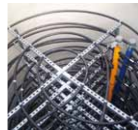
Warmtewisselaar voor onttrekking van warmte in ijsreservoir
