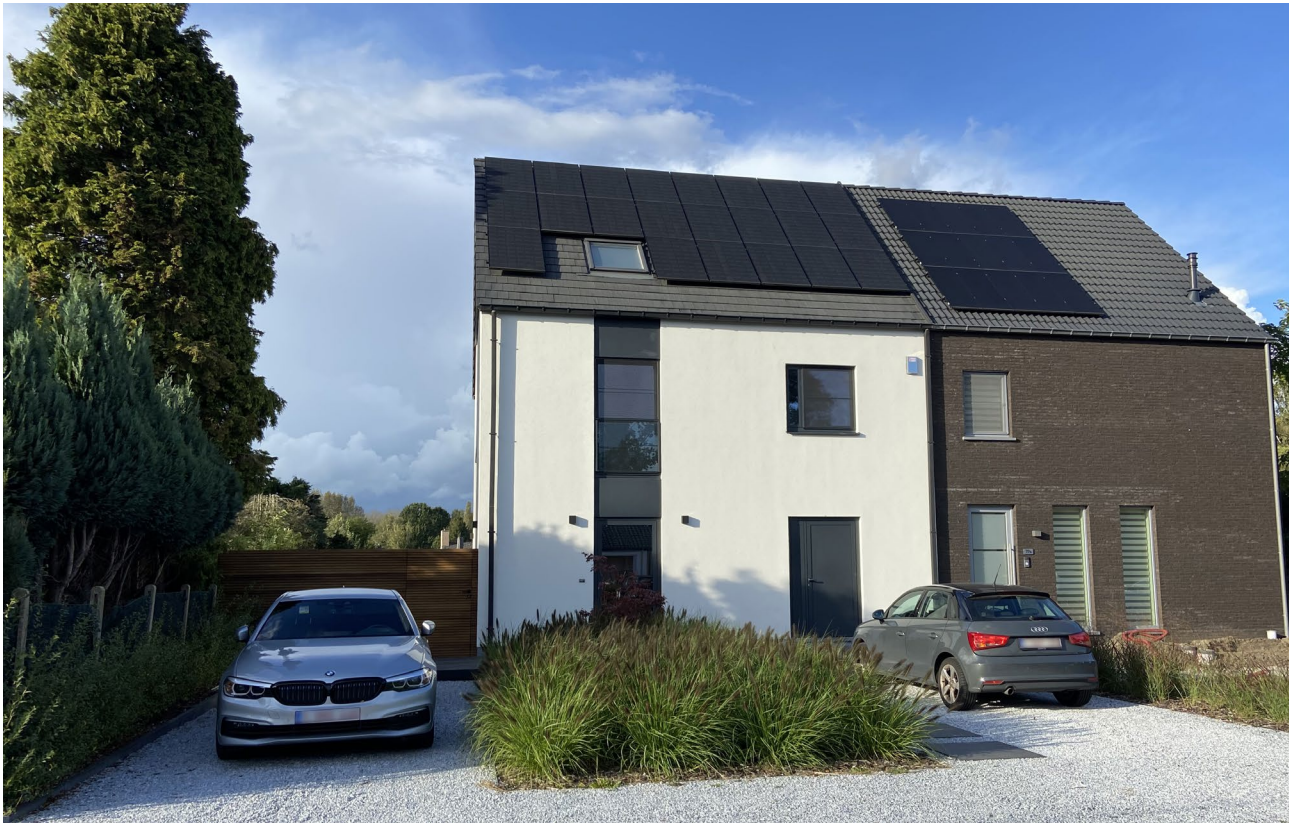
Nieuwbouwwoning van 200 m 2 (bouwjaar 2021), met een lucht/water-warmtepomp en zonnepanelen voor optimaal gebruik van de thermische zonne-energie.
