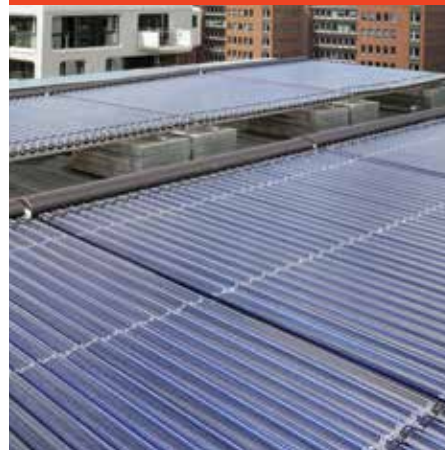
Fig. 3.4 Liggende vacuümbuiscollectoren
